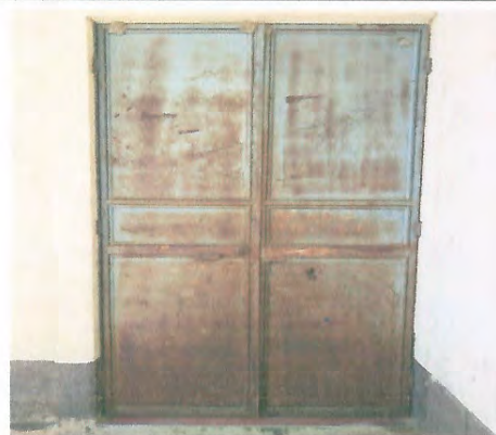
Foto 6: Cambio de puerta en aula en el área este de la escuela.
