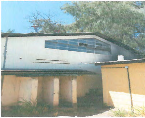
Foto 5: Cambio de vidrios de ventanales en Anexo 3
